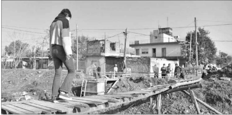
zar con la colocación de los perfiles de la estructura, que va a sostener el puente, y luego la pasarela por donde vamos a transitar. Finalmente, se completará con la ejecución de las rampas y la colocación
